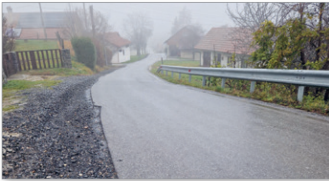
Območje obnove vodovoda Cenkova-Cogetinci
