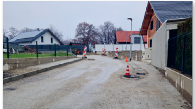
Novo naselje Cogetinci pred končno ureditvijo - asfaltiranjem
