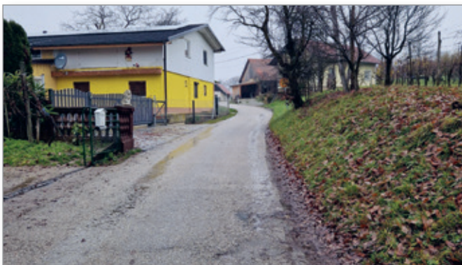
Naselje Grabonoški Vrh, predvideno za obnovo vodovoda
