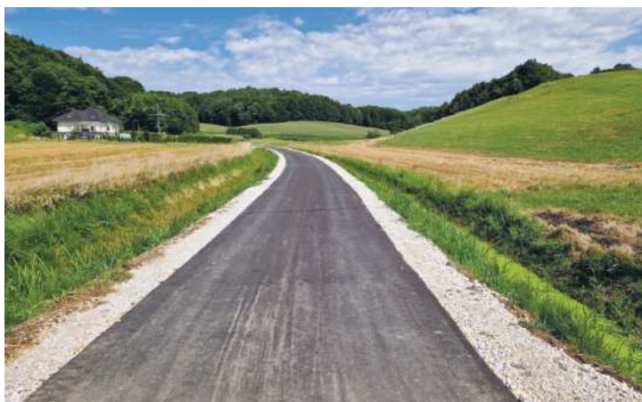
Cestišče na novem odseku ceste Brengova–Vodule–Vanetina, ki bo povečal prometno varnost na tej relaciji, je široko 3,5 metra, ob njem pa so bankine in globoka mulda za odvodnjavanje.
