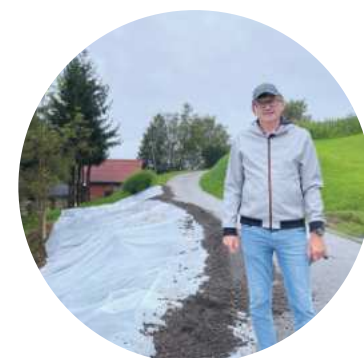
Župan Martin Breznik na ogledu zemeljskih plazov na Kremberku.
