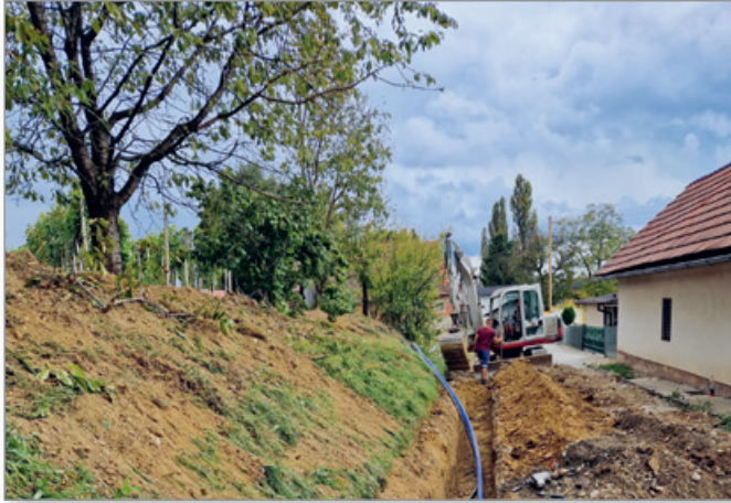
Obnova vodovoda v naselju Grabonoški Vrh
