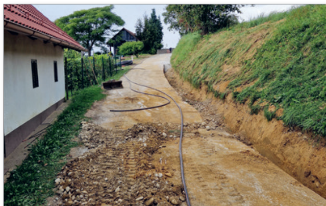
Sočasna izgradnja optike in vodovoda – naselje Grabonoški Vrh
