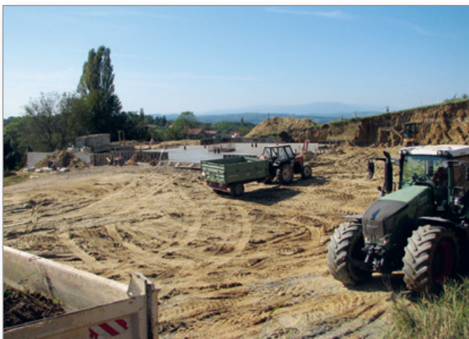
Pogled na območje gradnje dveh stanovanjskih blokov, foto F. B.
