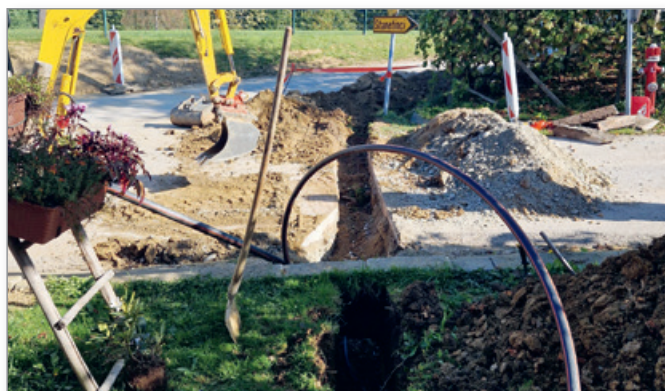
Izgradnja optike in vodovoda – naselje Andrenci in Stanetinci
