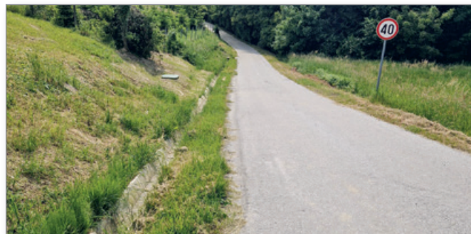
Obnova vodovoda v naselju Cenkova-odsek Rajh
